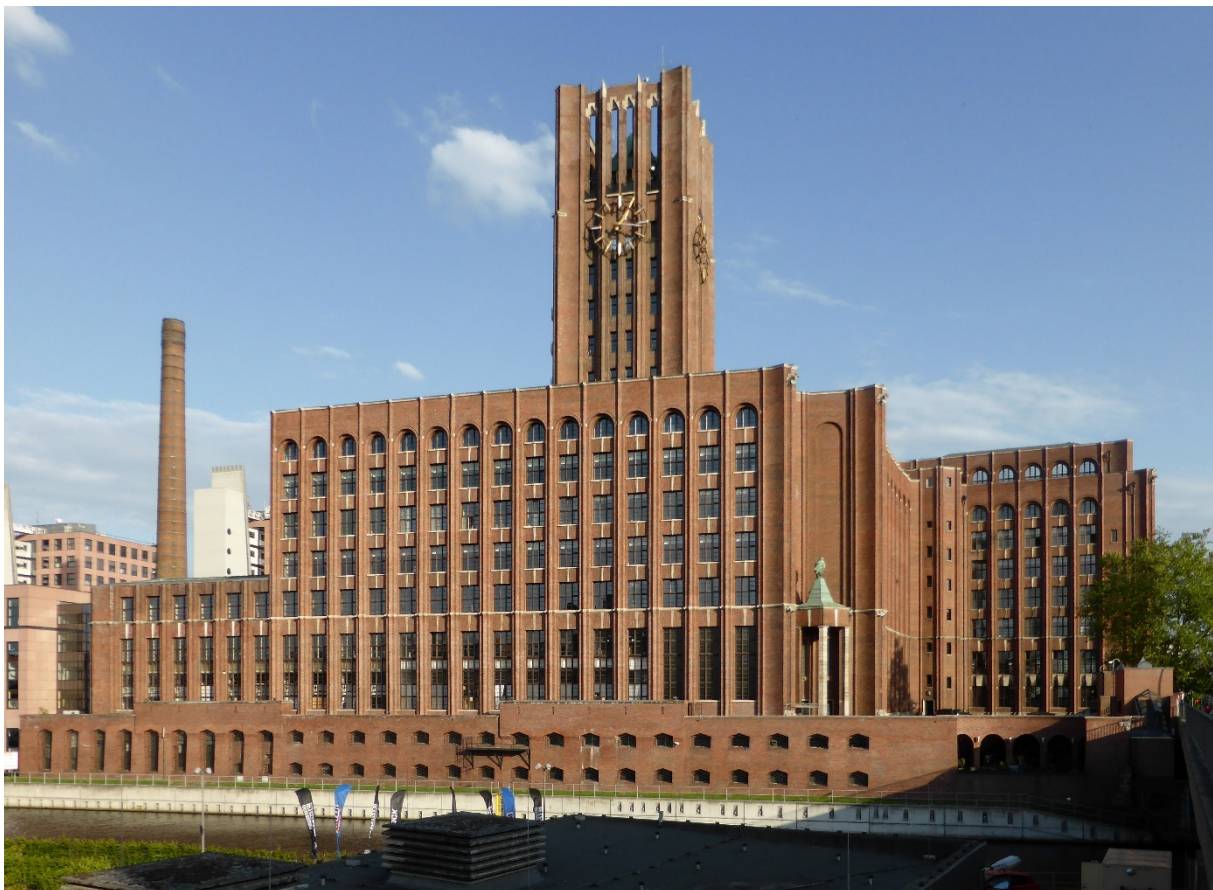
Abbildung 7: Das Ullsteinhaus, Bürostandort der Grün Berlin GmbH von Seiten des Tempelhofer Hafens aufgenommen. (Quelle: Dirk Ingo Franke - Eigenes Werk, CC BY-SA 4.0, https://commons.wikimedia.org/w/index.php?curid=40939860 )
